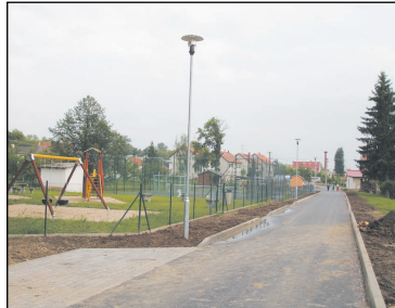
Místní komunikace, osvětlení hřiště.
